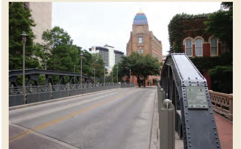
Historic N. Presa St. Bridge, c. 1925
